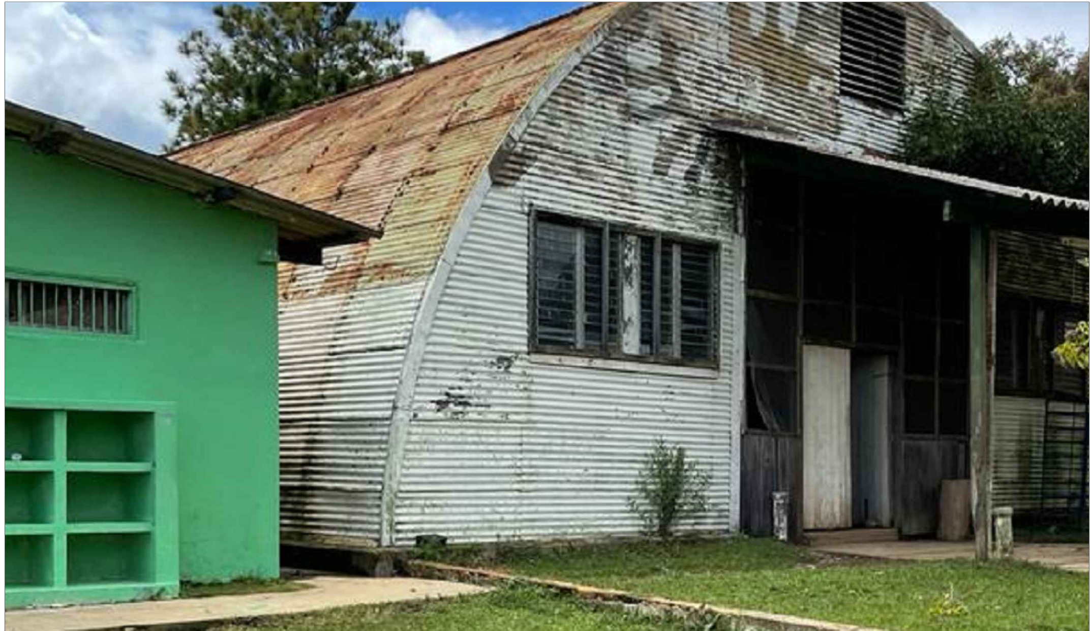
Condición actual comedor (entrada posterior) Current Mess Hall roof condition (back entrance)
