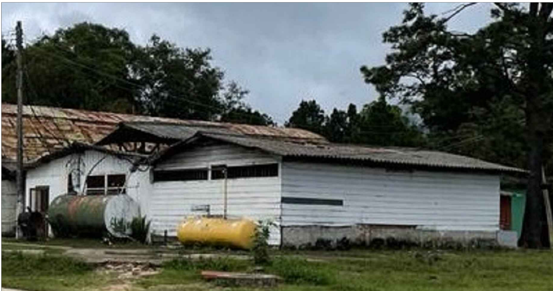
Eje I - Paredes exteriores de adobe y de madera; techo de láminas de asbestos y ventanas de tela mosquitera Axis I - Exterior Adobe and wooden walls; asbestos sheet roofing and screened windows
