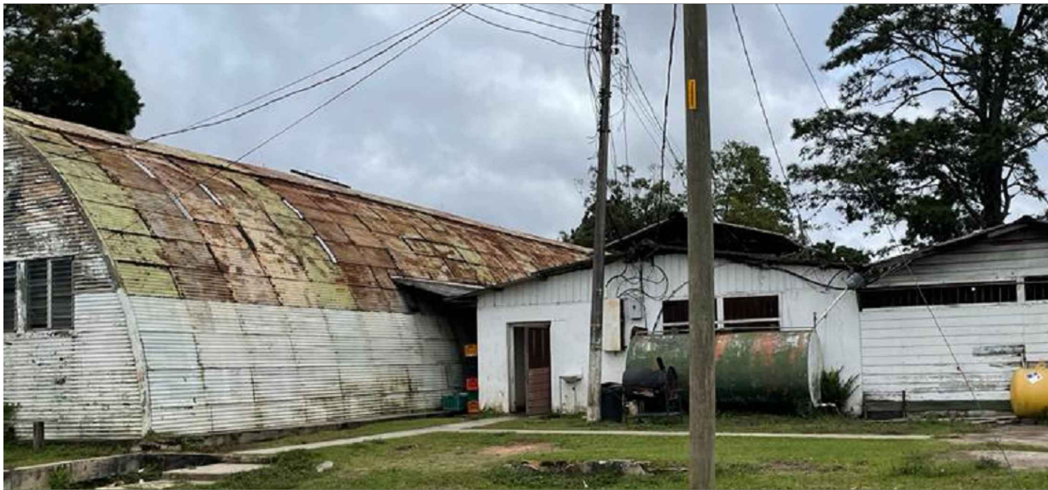
condición actual cocina y alacena (Current Warehouse & kitchen Condition)
