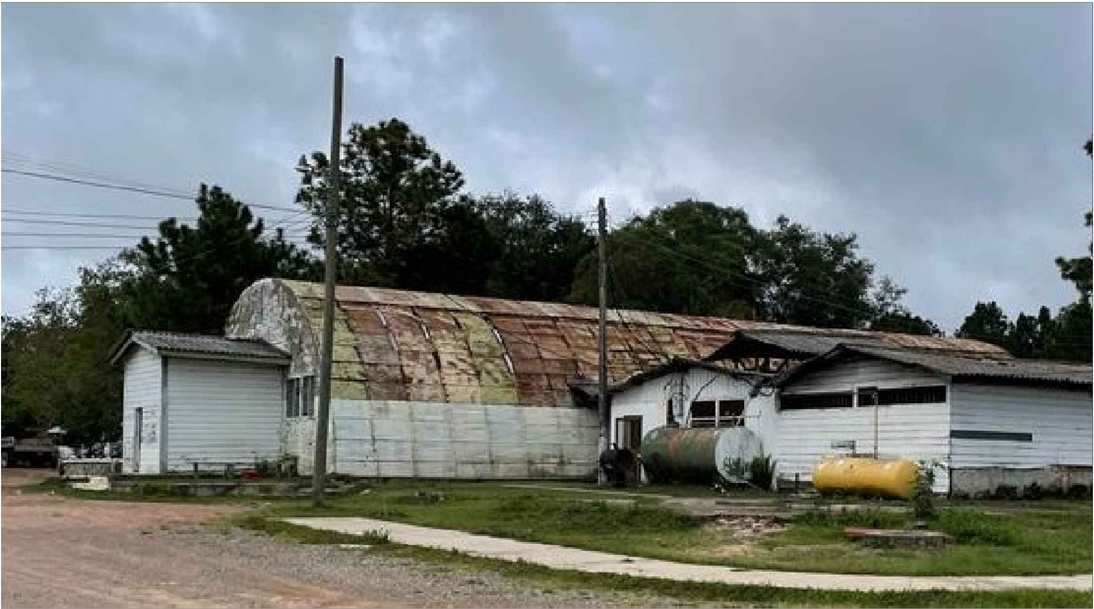
Condición actual techo de comedor (frontal) Current Mess Hall roof condition (front)
